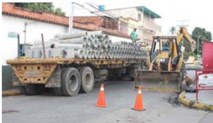
Las tuberías serán completamente instaladas en ocho días
